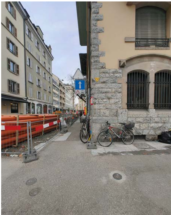
Chemin menant à l'accès PMR de l'Espace Pitoëff
