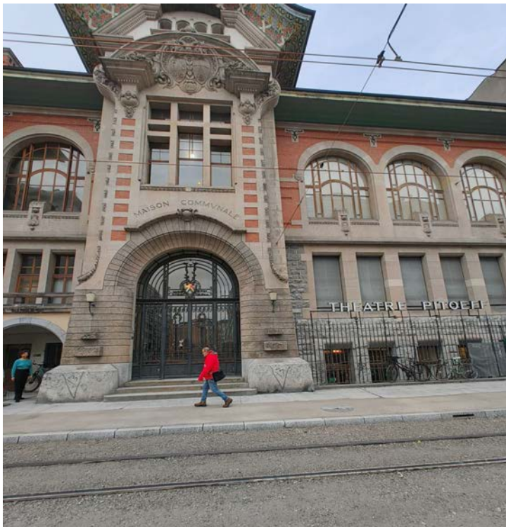
Entrée du bâtiment de l'Espace Pitoëff
