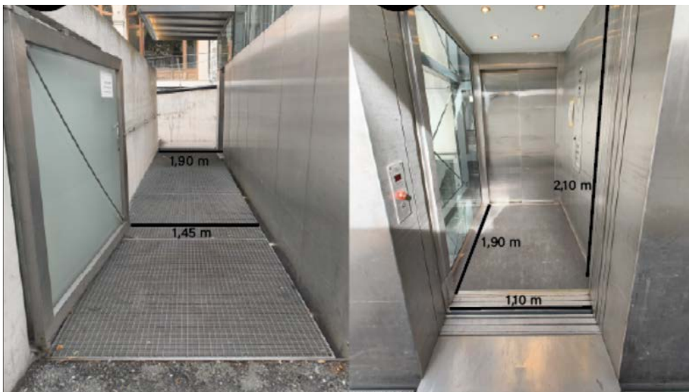
Mesures de l'accès à l'ascenseur et mesures de la porte et de l'intérieur de l'ascenseur
